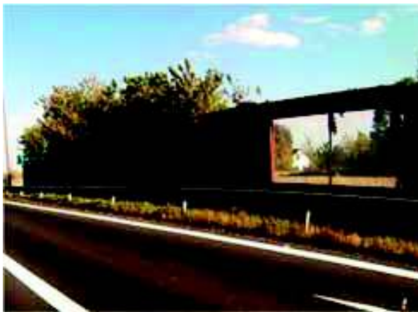
Fot. 1. Droga nr 5/S5 na odcinku Dworzysko – Trzeciewiec (Fot. M. Pakuła)
