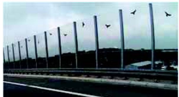
Fot. 2. Autostrada A4, obwodnica Krakowa (Fot. M. Pakuła)
