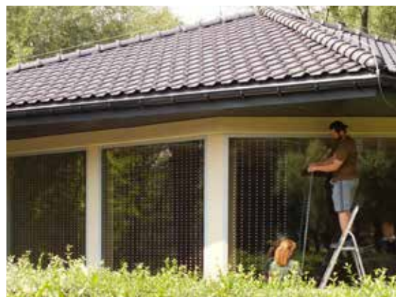
Naklejki zabezpieczające szyby przed kolizjami z ptakami muszą być rozmieszczone odpowiednio gęsto, by zadziały.
